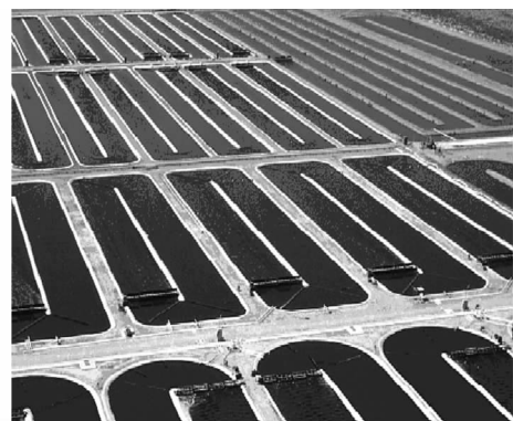
图3 带浆轮搅拌装置的沟式氧化塘生产现场
